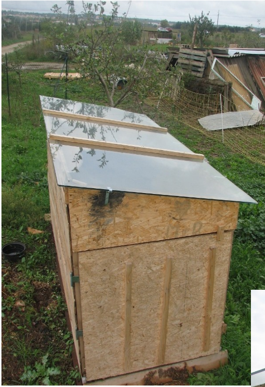
Pose du vitrage en toiture (4 à 8 mm)
